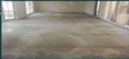
Project : Bukit Golf Internasional, Surabaya Pekerjaan : Self Leveling lantai
